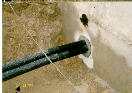
MSH Außenansicht und Schutzrohrbündel im gemeinsamen Rohrgraben
